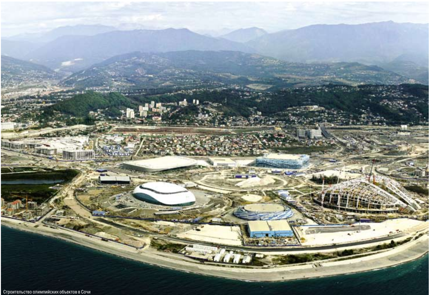
Строительство олимпийских объектов в Сочи
